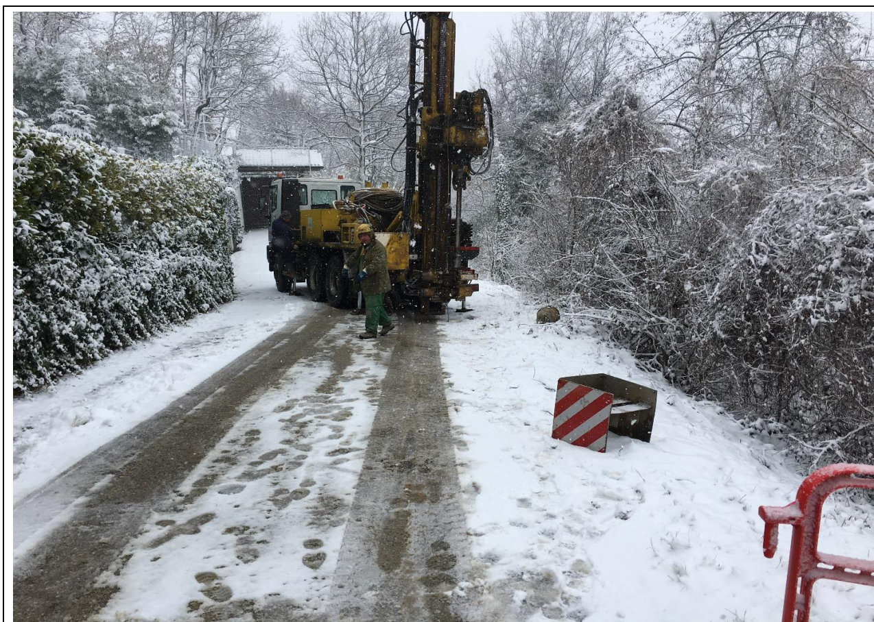
Fig. 7. Fasi di perforazione
